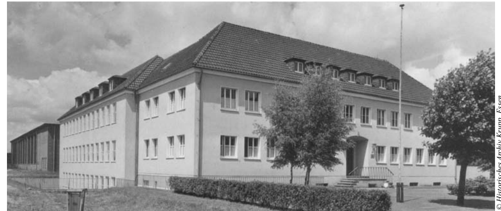
Verwaltungsgebäude von Koppers-Wistra an der Wiesenstraße
