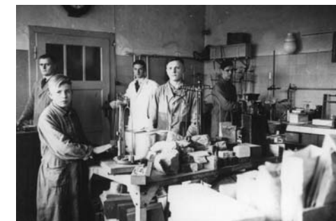
In den Laboratorien erfolgte die Qualitätskontrolle der Produkte und die Neuentwicklung feuerfester Materialien.
